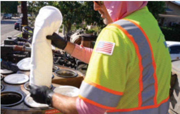
Trabajadores insertando filtros limpios en el sistema NO-DES antes de otra ronda de lavado.
